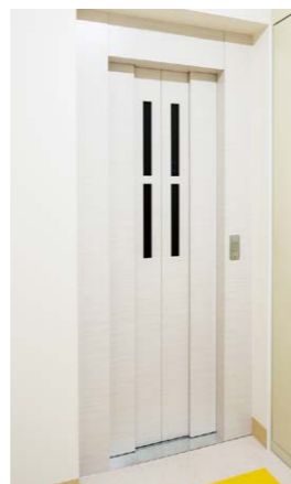
元学習塾を改装し、足が不自由な人や車いすの人も利用できるようエレベーターを設置しています
